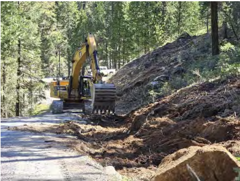
Sta 7+80 looking NE
