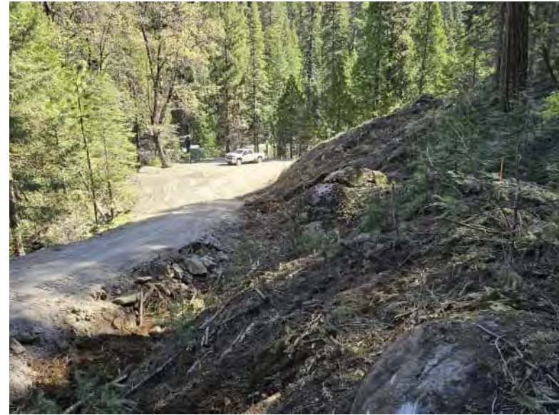
Sta 7+75 looking NE
