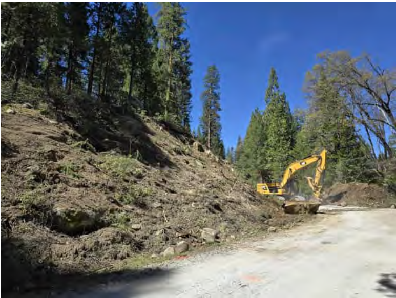
Sta 10+00 looking W
