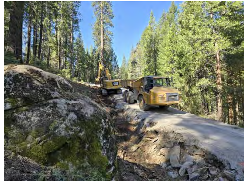
Sta 8+60 looking W
