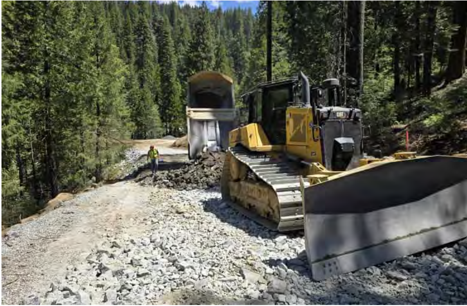
Sta 7+00 looking NE
