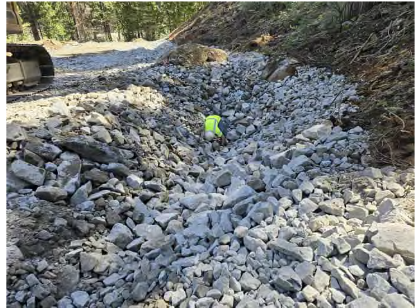
Sta 7+50 looking NE
