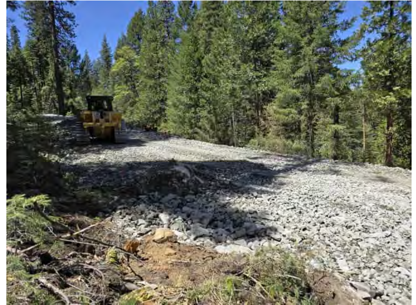
Sta 8+50 looking W
