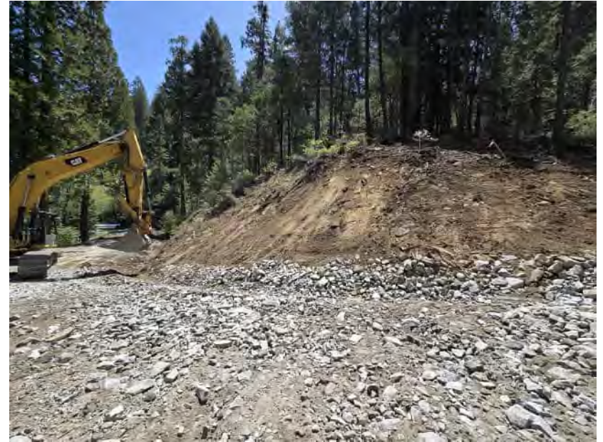
Sta 9+50 looking E
