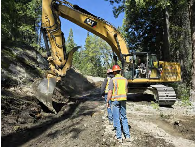
Sta 10+90 looking W
