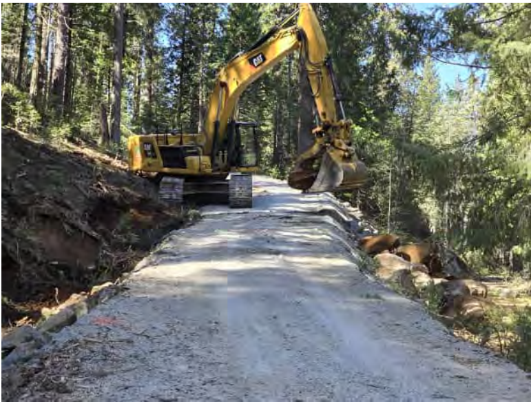
Sta 8+50 looking SW
